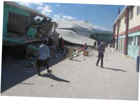
2010 Zerstörtes Schulgebäude nach dem Beben in Haiti
