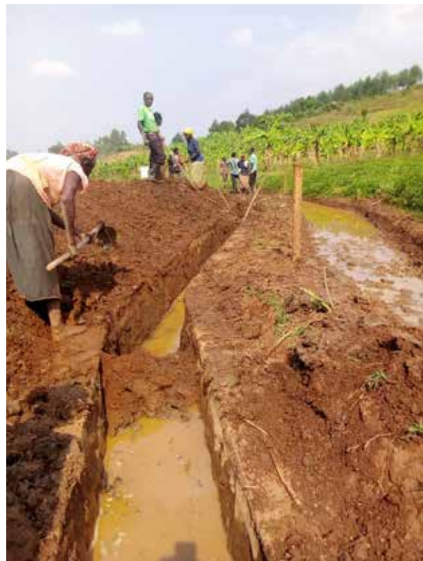
Für den Ablauf des Regenwassers wird ein zusätzlicher Wasserkanal gezogen
