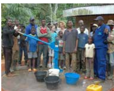
2015 Brunnenbau in Kamerun
