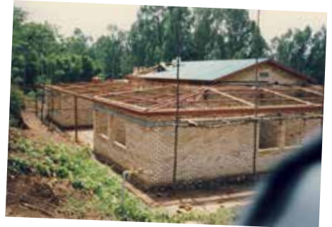
1991 Neubau im Straßenkinderprojekt INTIGANDA in Butare, Ruanda
