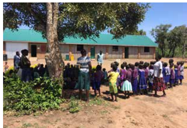
Der St. Mary-Kindergarten ist einer der vier neu gebauten Vorschulkindergärten in Palabek
